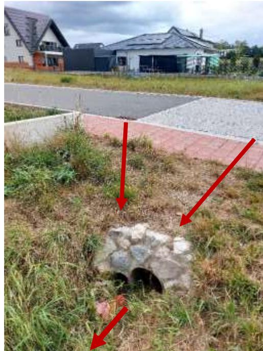
Abbildung 3-1: Entwässerung im Südwesten des Baugebiets
